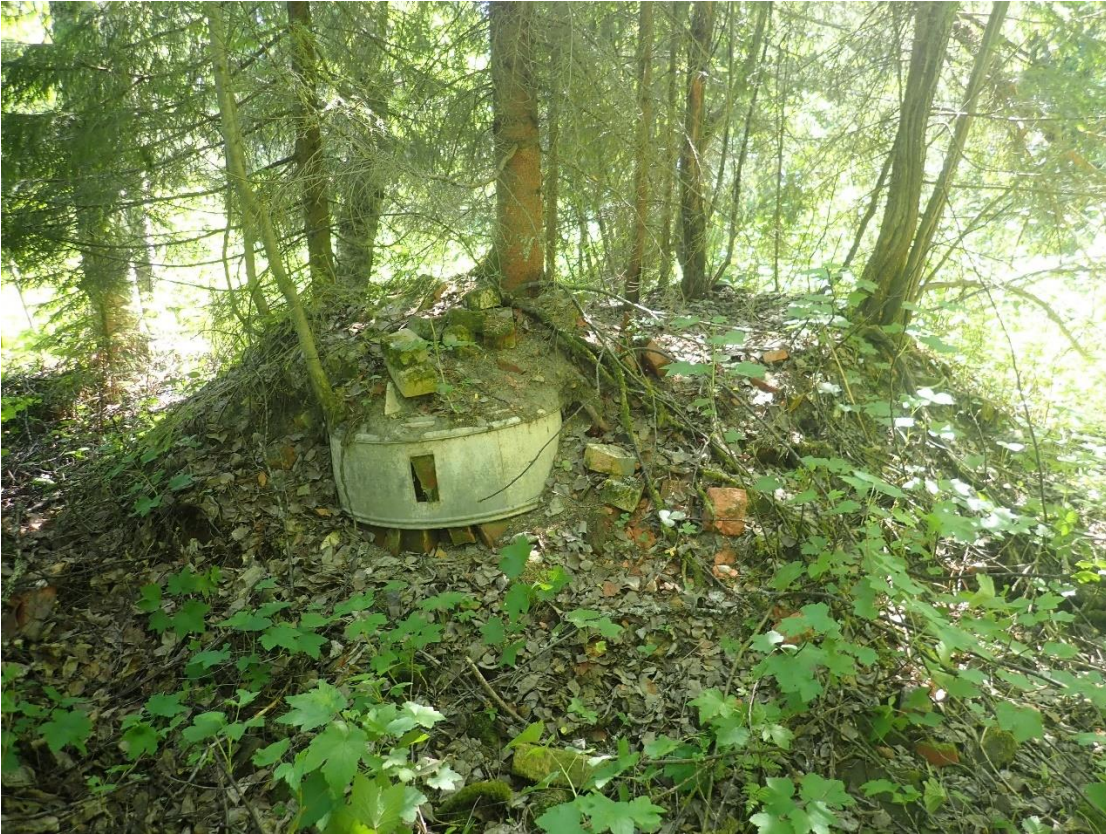
Kuva 18. Lätisemmän rakennuksen pohjan sisällä oli peltiroskaa sekä tiilenpaloja. Kaakkoon.
